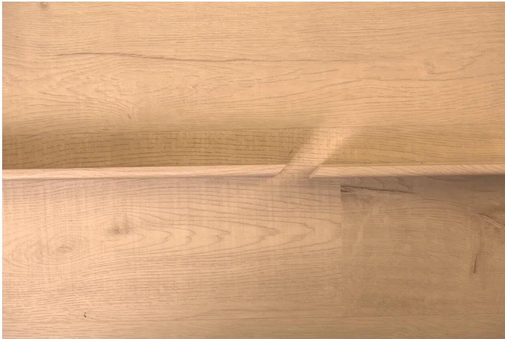
Запил для внешнего соединения производится под углом 45 градусов
